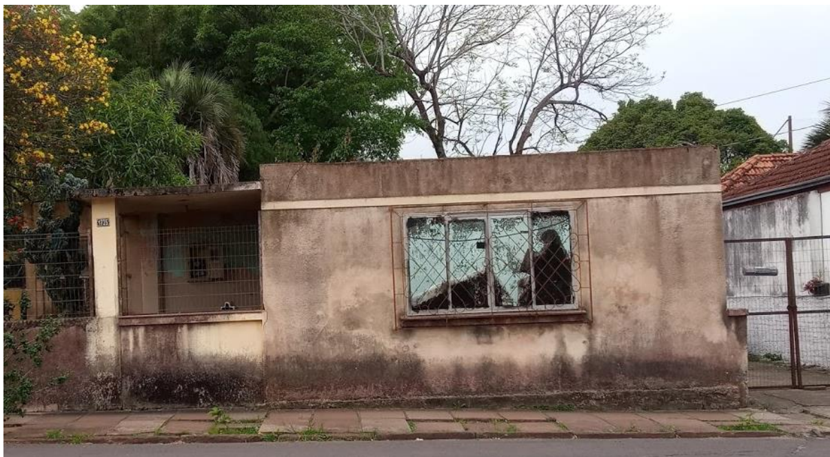
Figura 2 - Fachada da casa em ruína. Fonte: Acervo pessoal (2020).
