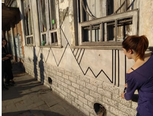
Figura 4: Etapa final da intervenção.
