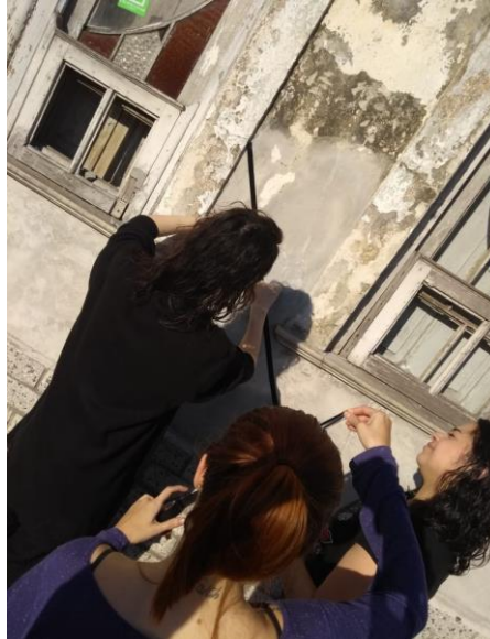
Figura 2: Início da intervenção.
